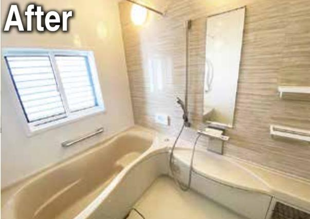
施工内容：トクラスユーノベース 1.25坪 人造大理石浴槽 断熱・保温仕様 換気暖房乾燥機
